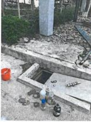
生活废水处理前检测点
